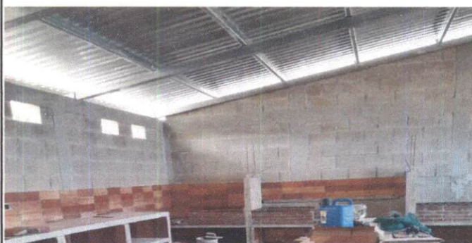
REMODELACIÓN DE COCINA
