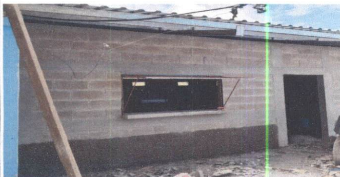
REMODELACIÓN DE COCINA
