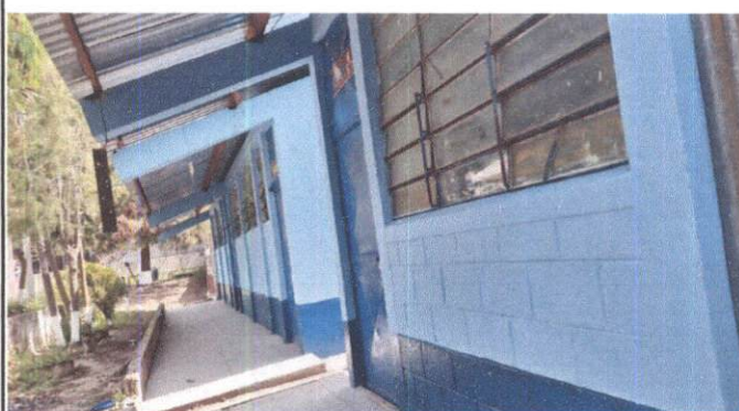
PINTURA DE MURO INTERIOR Y EXTERIOR
